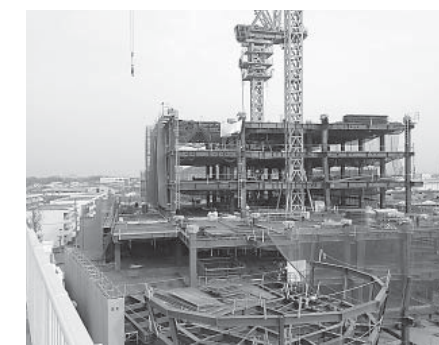
新病院建設工事(いよいよ来春完成)
