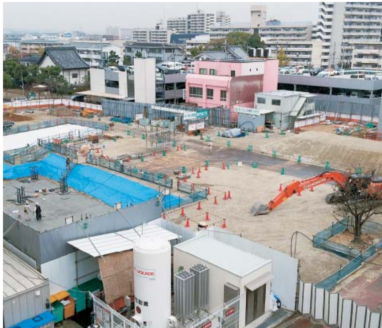
グランドオープンにむけ工事がすすんでいます
