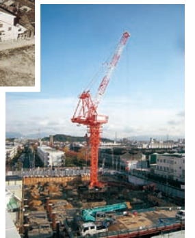
新病院建設中
